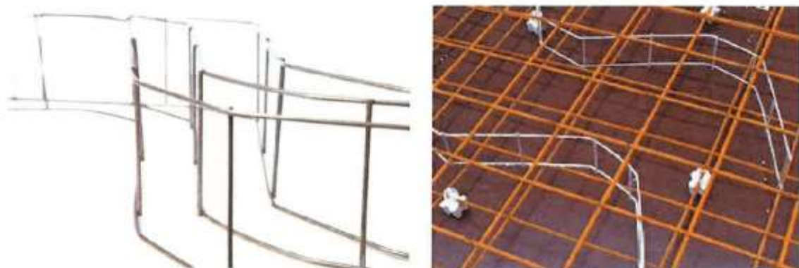
Slika 2. Prikaz izgleda i ugradnje distancera
